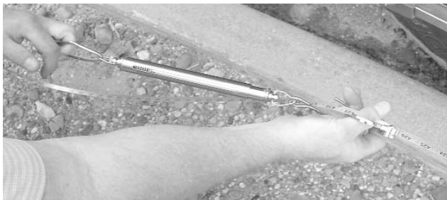
Figura 22. Usando la herramienta tensora de la cinta
